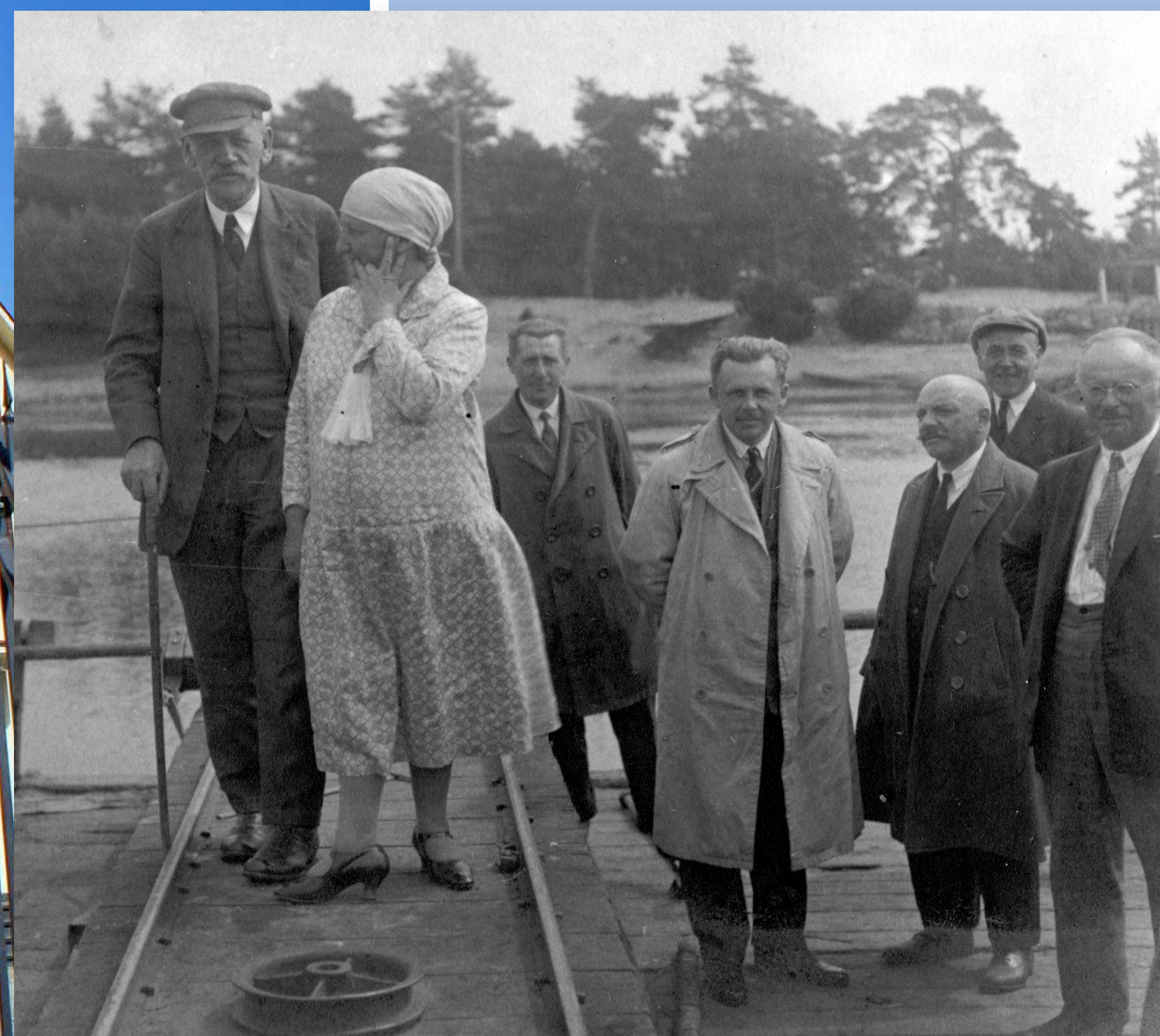
Zofia i Jędrzej Moraczewscy (pośrodku) podczas wizytacji robót publicznych na Niemnie pod Ogrodnikami, na drodze Nowogródek – Lida.
